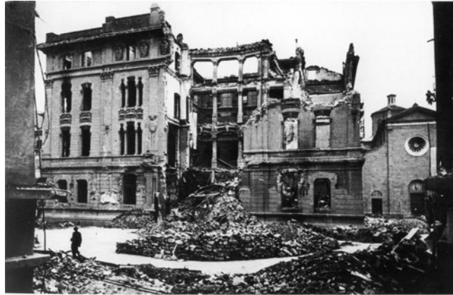
Il Palazzo "Cenere", sulla destra il Duomo di S. Maria prima della ristrutturazione
