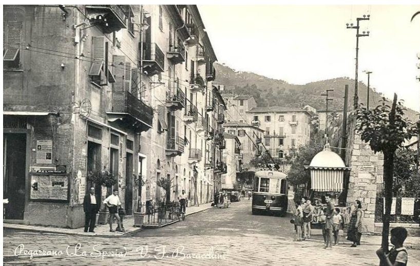
Figura 3. Pegazano nei primi anni '50. Sulla destra si nota il muro di cinta, in corrispondenza dell'apertura.
